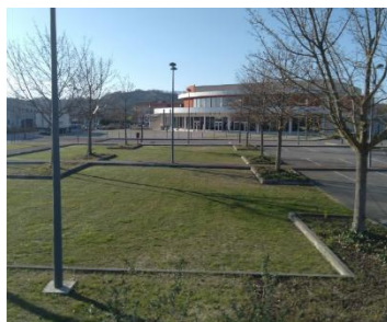
Revêtement enherbé sur support terre-pierre
