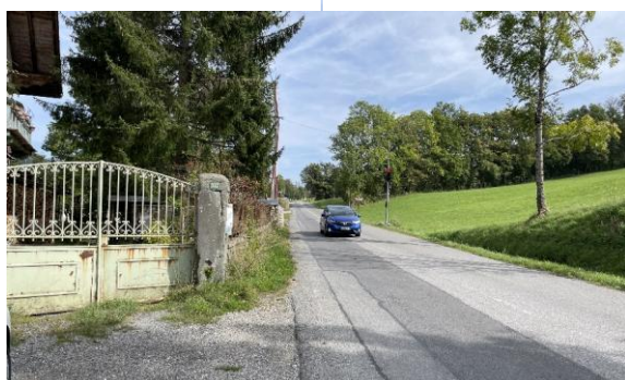
Clôture sur rue. Fin du talus et effet de porte végétale
